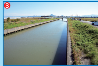
新守山川。両岸がコンクリート護岸になっている。春は水温が上がり始める時期が早いので、ベイトフィッシュや大型バスが入る。足もとの護岸に沿って巻き物を引くのがオススメ
